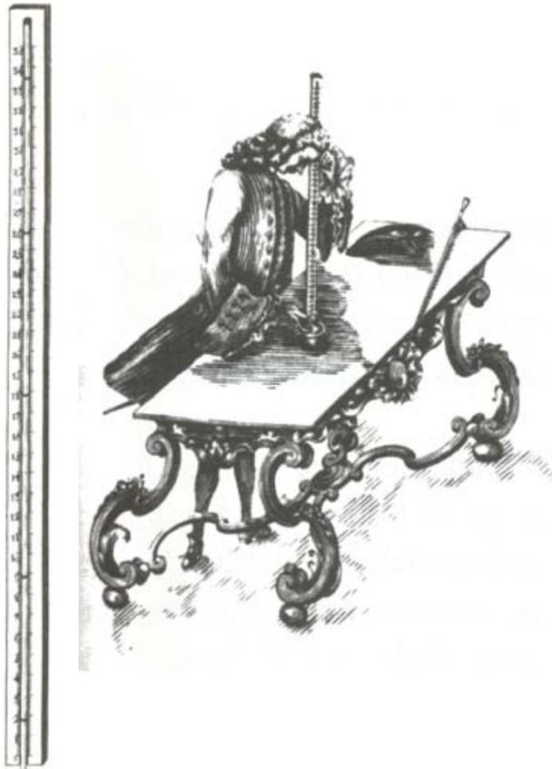
Figura 4.22: Dibujo del barómetro utilizado por Jorge Juan en el Ecuador y detalle del tubo de mercurio. Juan y Santacilia, Jorge & Antonio de Ulloa, Observaciones astronómicas y físicas hechas por orden de S.Mag. en los Reynos del Perú de las cuales se deduce la figura y magnitud de la tierra y se aplica a la navegación, página 119, Juan de Zúñiga, Madrid. 1748
