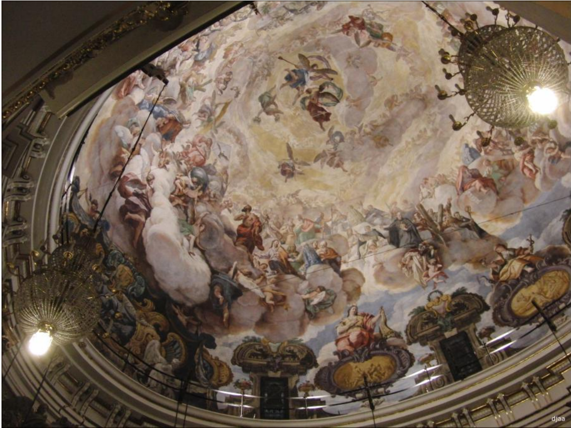
Fig 11. Vista de la bóveda añadida en 1701
