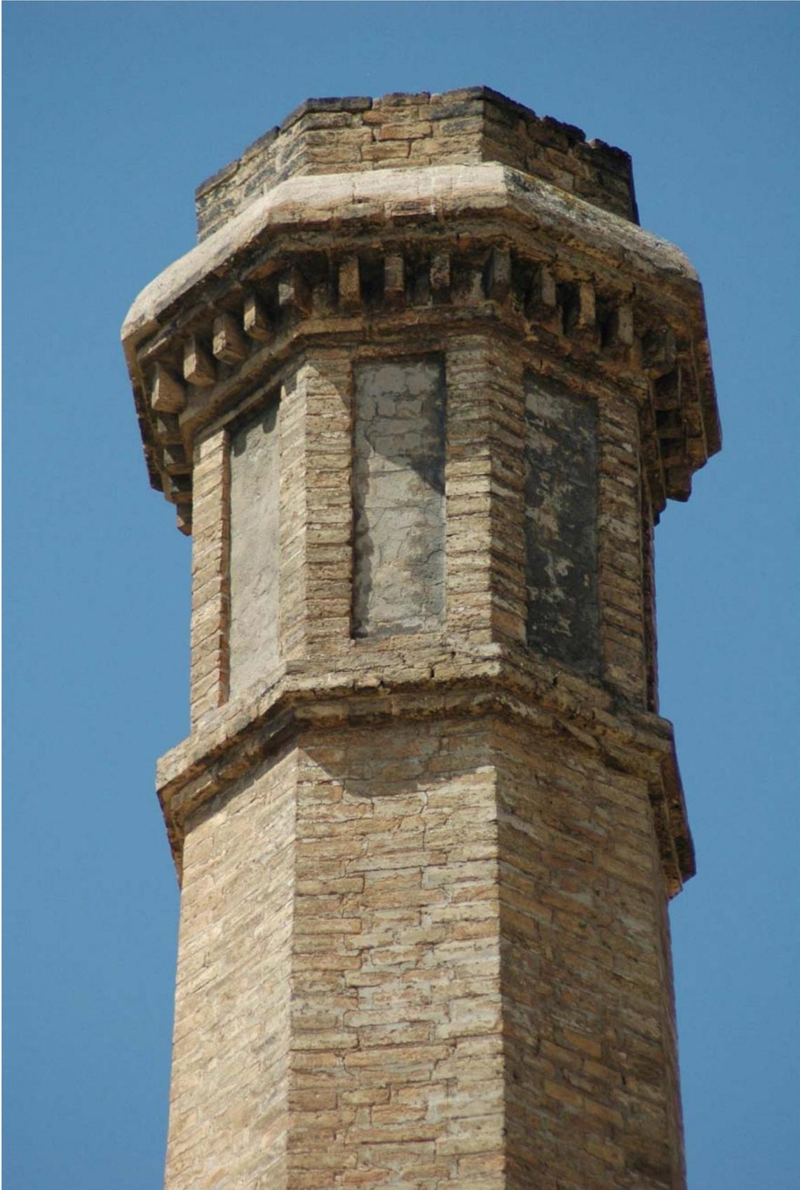
Figura 18: Corona de la chimenea de la Trilladora de Parsiego. Valencia
