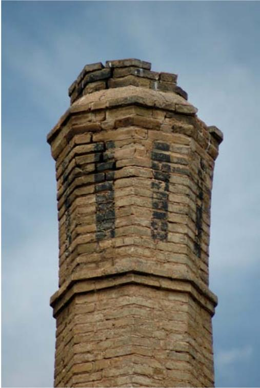
La separación con el fuste viene marcada por un par de hiladas o tres sobresalientes a modo de cornisa, que se repetirán antes de estrecharse finalmente para dar paso a la boquilla, formada a su vez por seis u ocho hiladas, de medio pie o un pie de espesor, dependiendo de la altura de la chimenea, sin pendiente alguna. El espacio intermedio entre cornisas varía de una a otra chimenea, pudiendo ser recto, sin pendiente alguna, o bien abierto en curvatura ascendente, en lo
