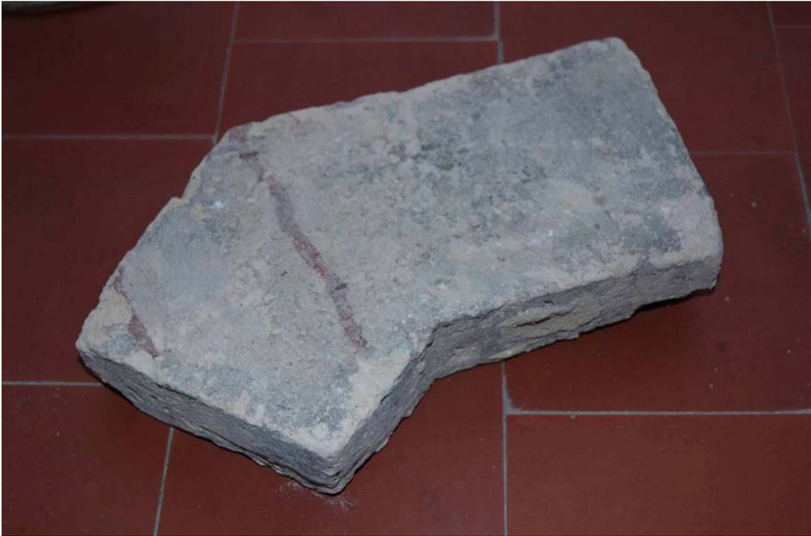
Figura 19: Ladrillo cerámico aplanillado de esquina correspondiente a una chimenea octogonal
