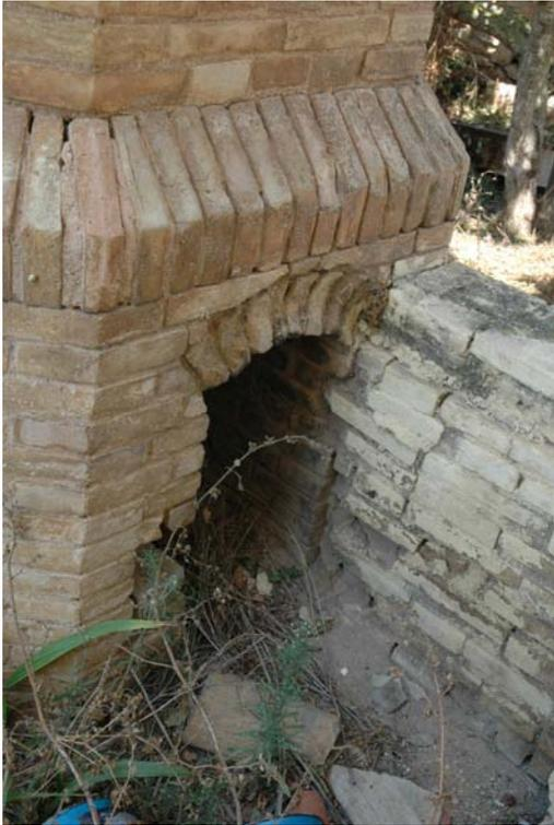
Figura 3: Conducto humos chimenea de motor Santa Ana. Picassent
