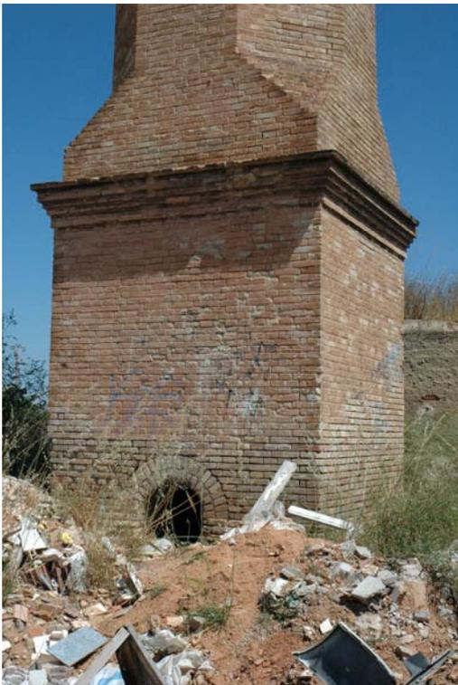
Figura 10: Base de sección cuadrada de Rajolar. Aldaia
