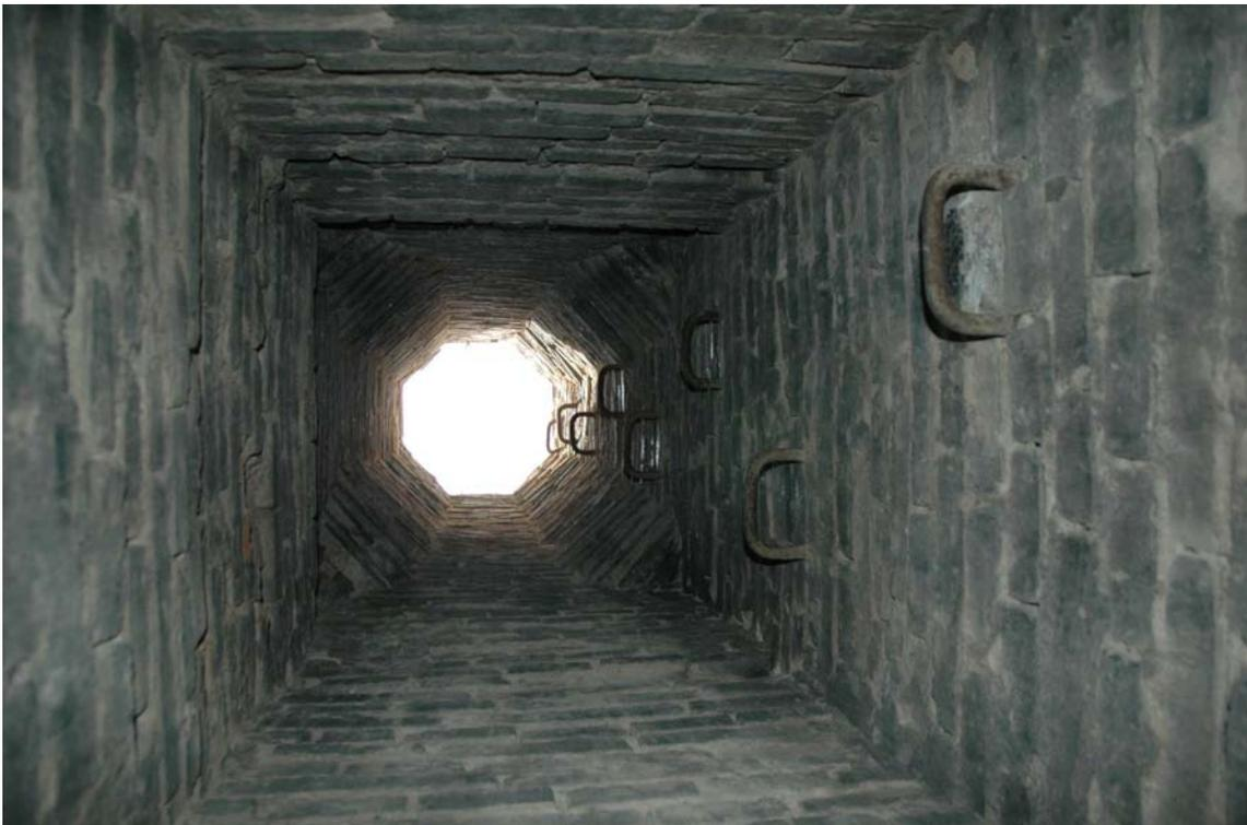
Figura 21: Interior de una chimenea con anillas para acceso vertical a la misma
