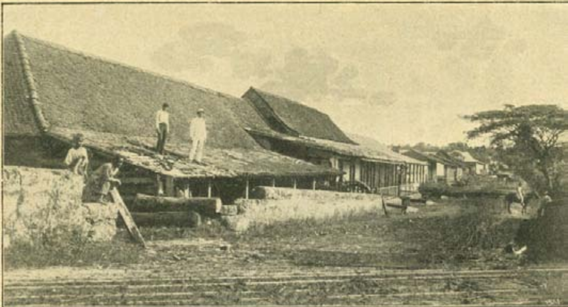
LA CALZADA REAL DE VUELTA ABAJO, EN ARTEMISA (CENTRO DE LA TROCHA DE MARIEL-MAJANA)
