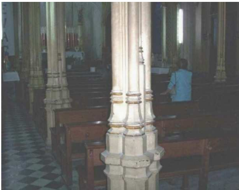
Vista interior de la capilla del Asilo del Marqués de Campo en la calle de la Corona (Valencia) Columnas de hierro, Fundición Vicente Ríos (1882-1884) Foto: Luis Mañas
