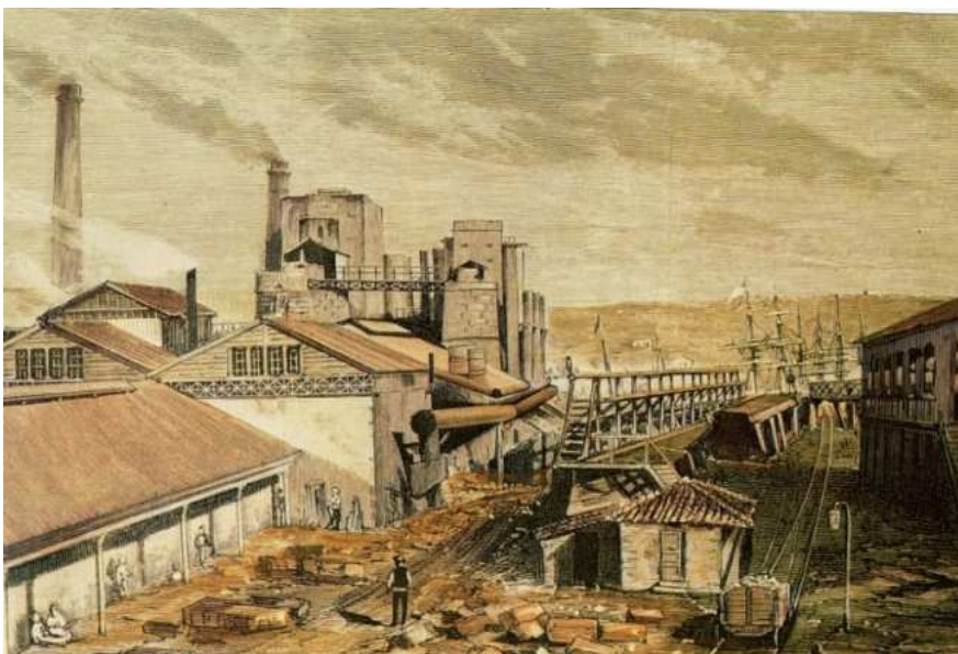
Vista de la fábrica del Carmen, en Baracaldo (Vizcaya, España) perteneciente a la Sociedad de Altos Hornos de Hierro y Acero.
