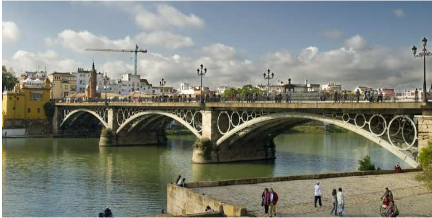
Puente Isabel II (Triana) Sevilla, sobre el río Guadalquivir.
