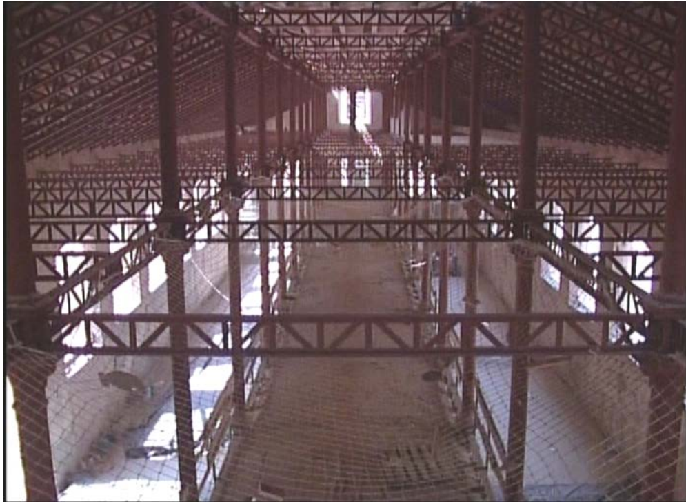
Estructura de de hierro fundido; cubierta, vigas, pilastra, zunchos etc.
