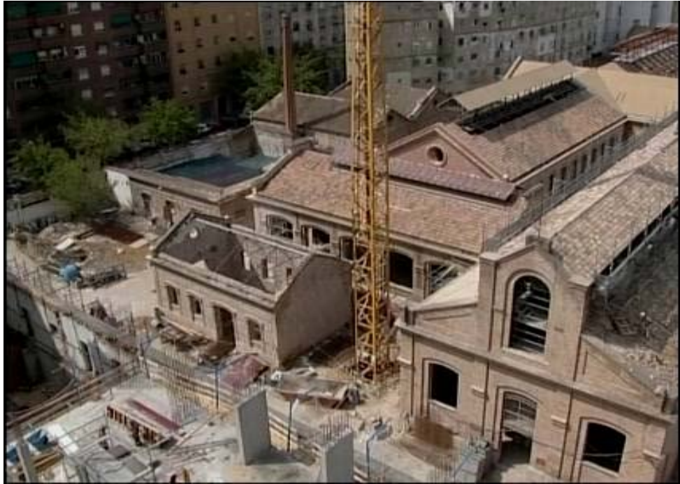
Vista de la obras durante su intervención © Archivo de la empresa constructora.
