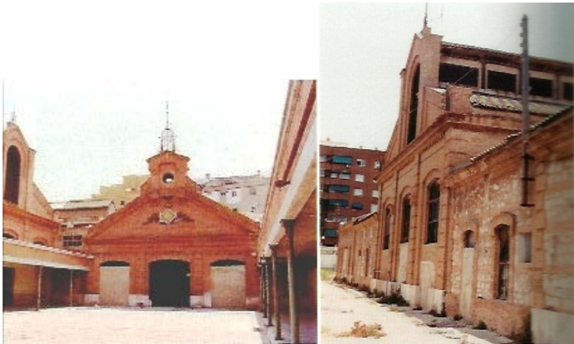
Patios interiores antes de su intervención © Archivo de la empresa constructora.
