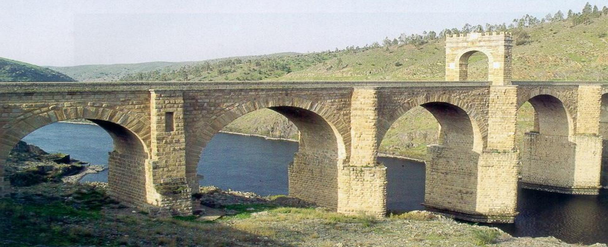
**<Puente de Alcántara, sobre el Tajo (Julius Lacer, siglos I y II, vanos de 28 m para alturas de pila de hasta 47 m)>**
