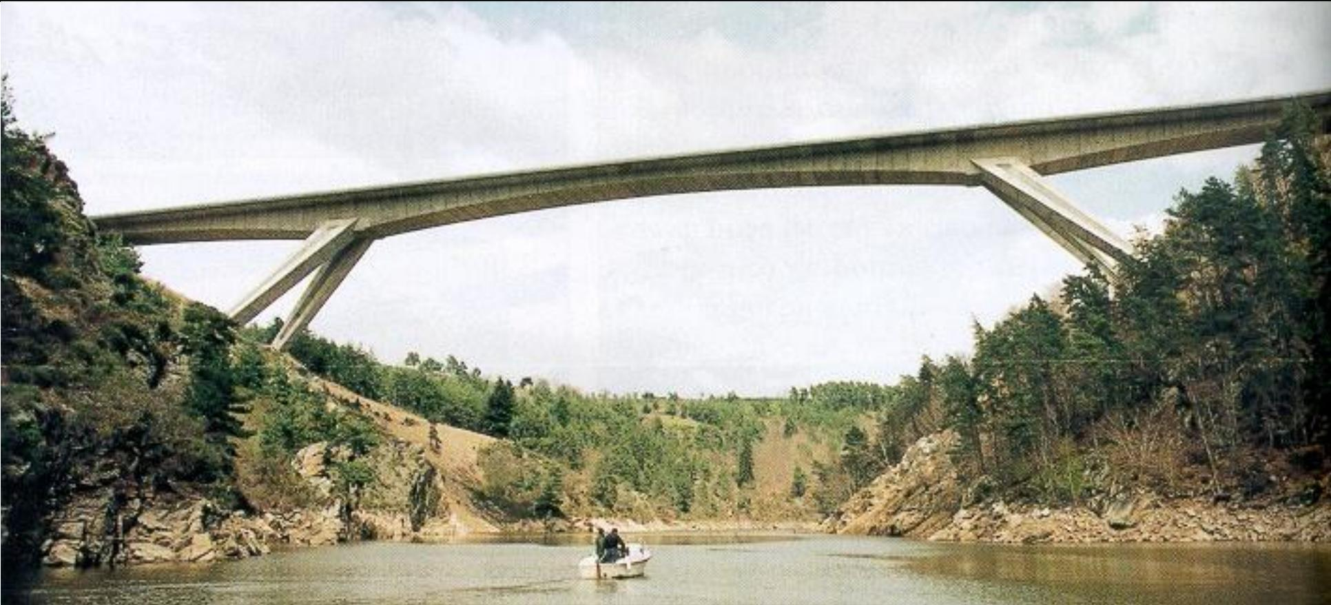
**<Puente sobre el Truyère (1993, pórtico de apoyos inclinados de 195.5 m de luz, construido mediante dovelas prefabricadas)>**
