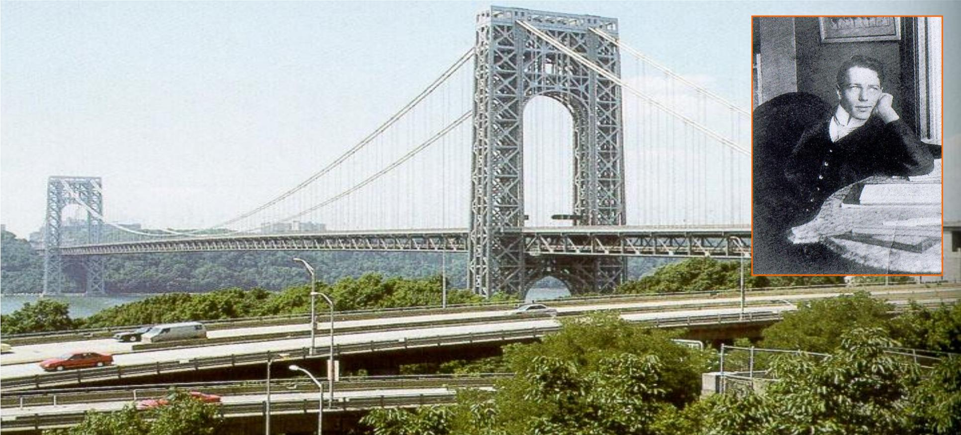
**<Othmar H. Ammann y el Puente George Washington, sobre el Hudson (Manhattan Norte, 1931, vano principal de 1031 m)>**
