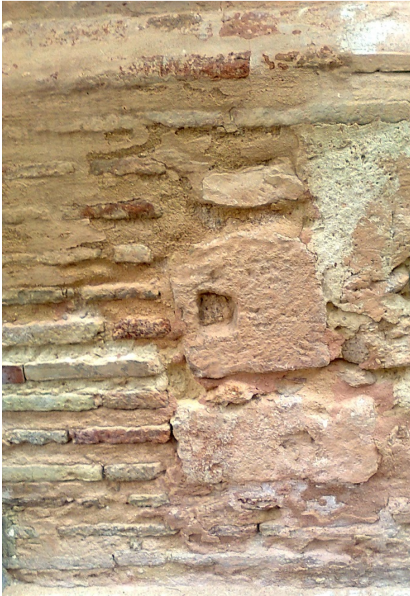
Muro sur de la actual iglesia con aprovechamiento de anteriores elementos de piedra
